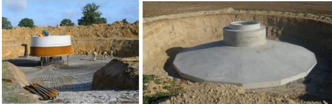
Le ferraillage et le coulage d'une fondation d'éolienne
